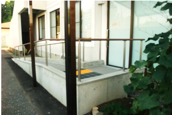
◎スロープになっており、安全です。
